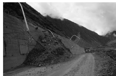
图 6 碎落滚石 Fig. 6 Rolling crashed stone
