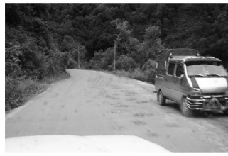
图 3 坑槽 Fig. 3 Pit slot
