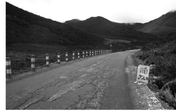
图 4 松散剥落 Fig. 4 Loose and spalling
