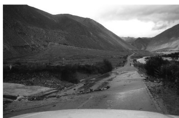
图 5 水毁导致沉陷 Fig. 5 Subsidence by water damage
