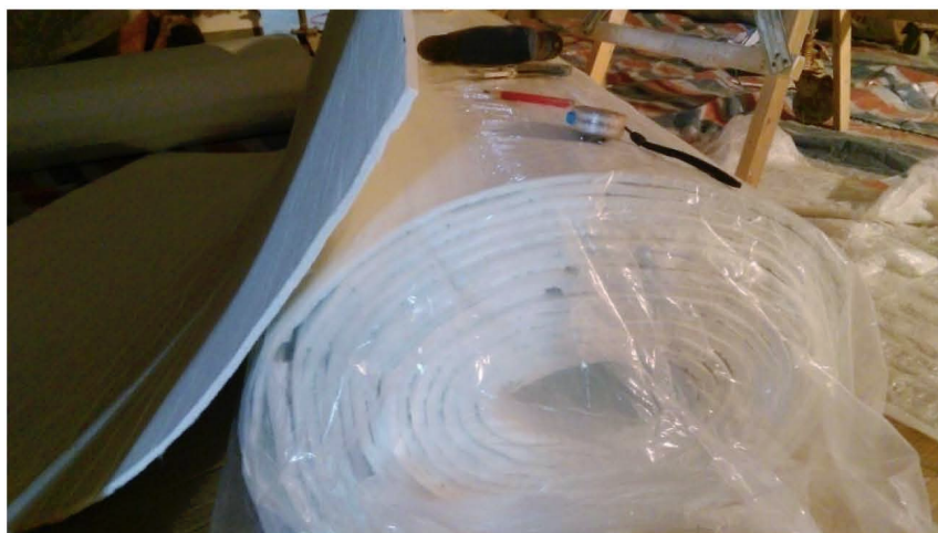
图 5.7 示范房间施工现场采用的纳米二氧化硅保温毡
